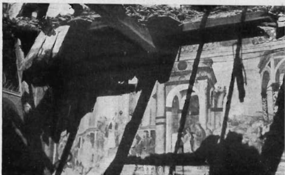
FIG. 17 - PADOVA, SCUOLA DEL CARMINE DOPO L'INCENDIO
