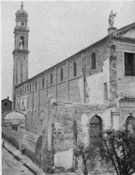
FIG. 15 - PADOVA, CHIESA DI S. BENEDETTO DOPO IL BOMBARDAMENTO
