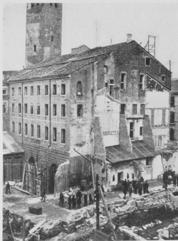
STATO ATTUALE DEI LAVORI INTORNO AL PALAZZO DEGLI ANZIANI.
