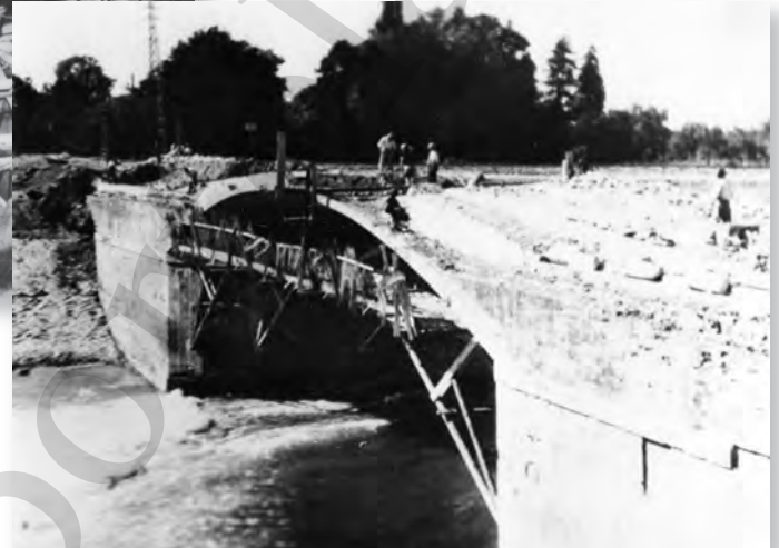
I lavori di demolizione del vecchio ponte in muratura del 1851.
