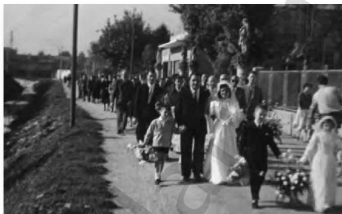
Via del Cristo con la canaletta scavata alla metà dell'800. (foto Romeo e Angelina Bortolami).
