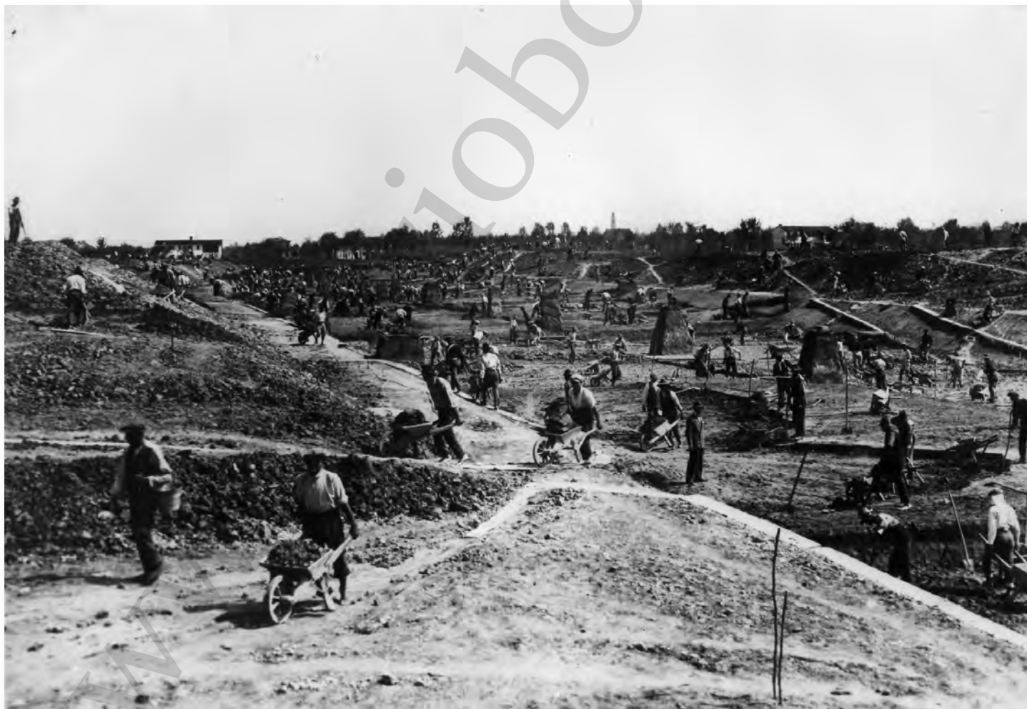
L'allargamento del canale Scaricatore negli anni '30.
