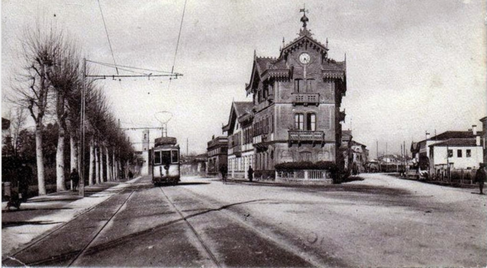
Padova - Viale Cavallotti al Bassanello
