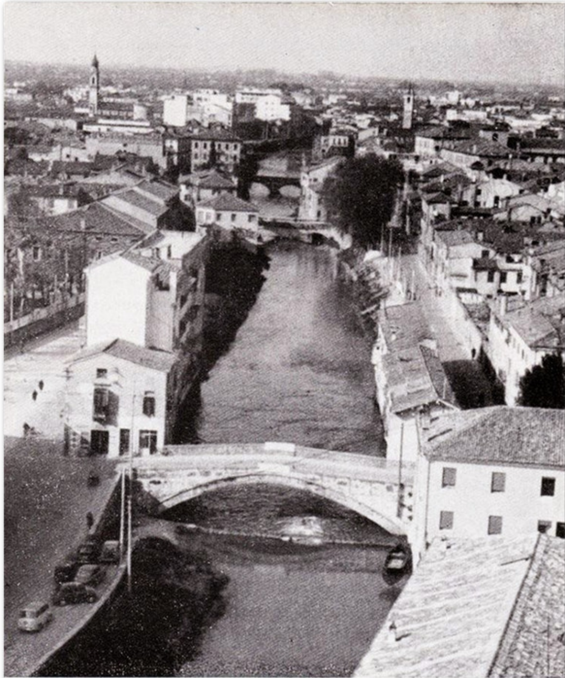
Fig. 328 - Ponte S. Agostino
