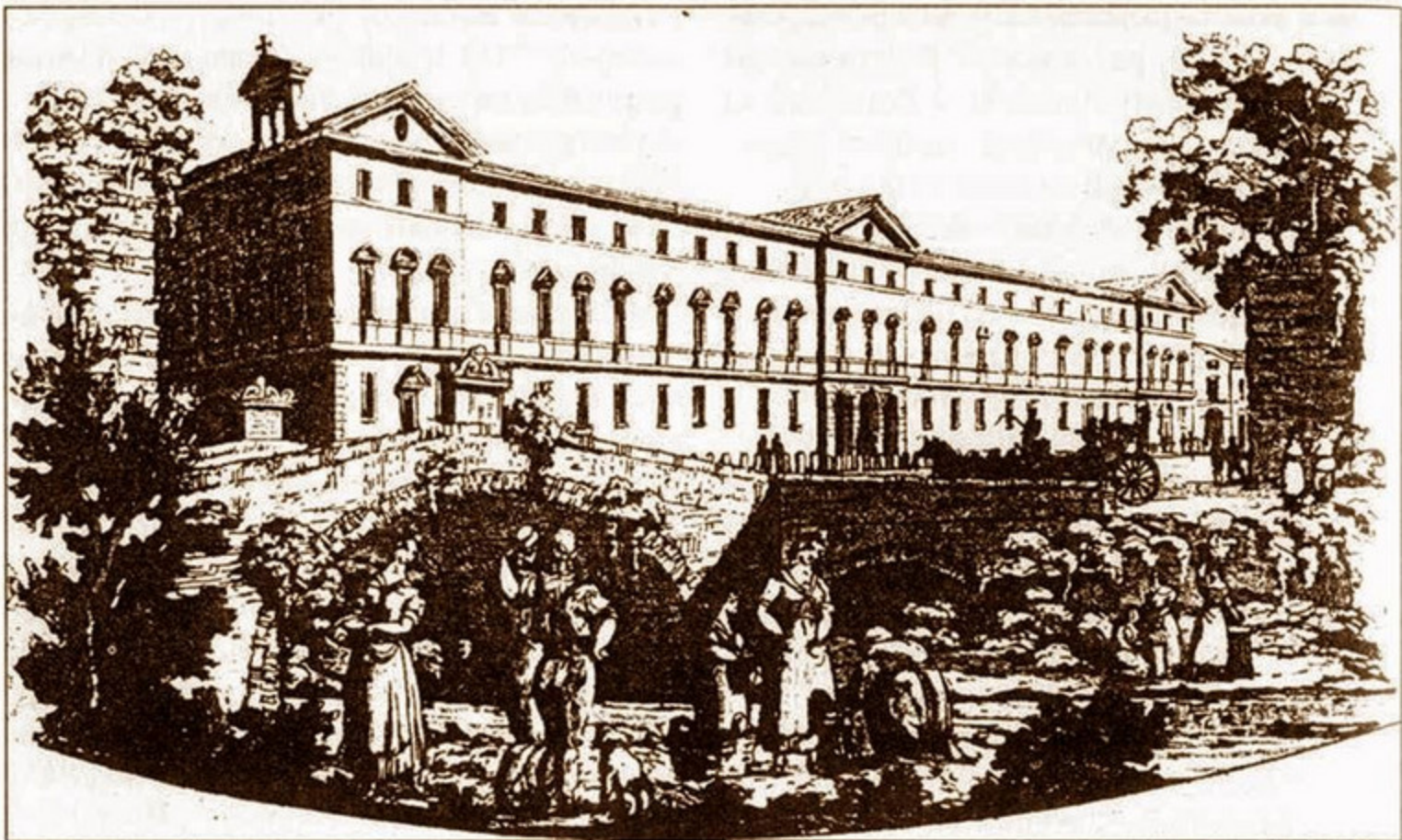
Disegno de "L'Ospitale Civile " di Pietro Chevalier, da "Memorie architettoniche", 1831. Allora era ancora in piedi il Ponte Piccoccioso.
