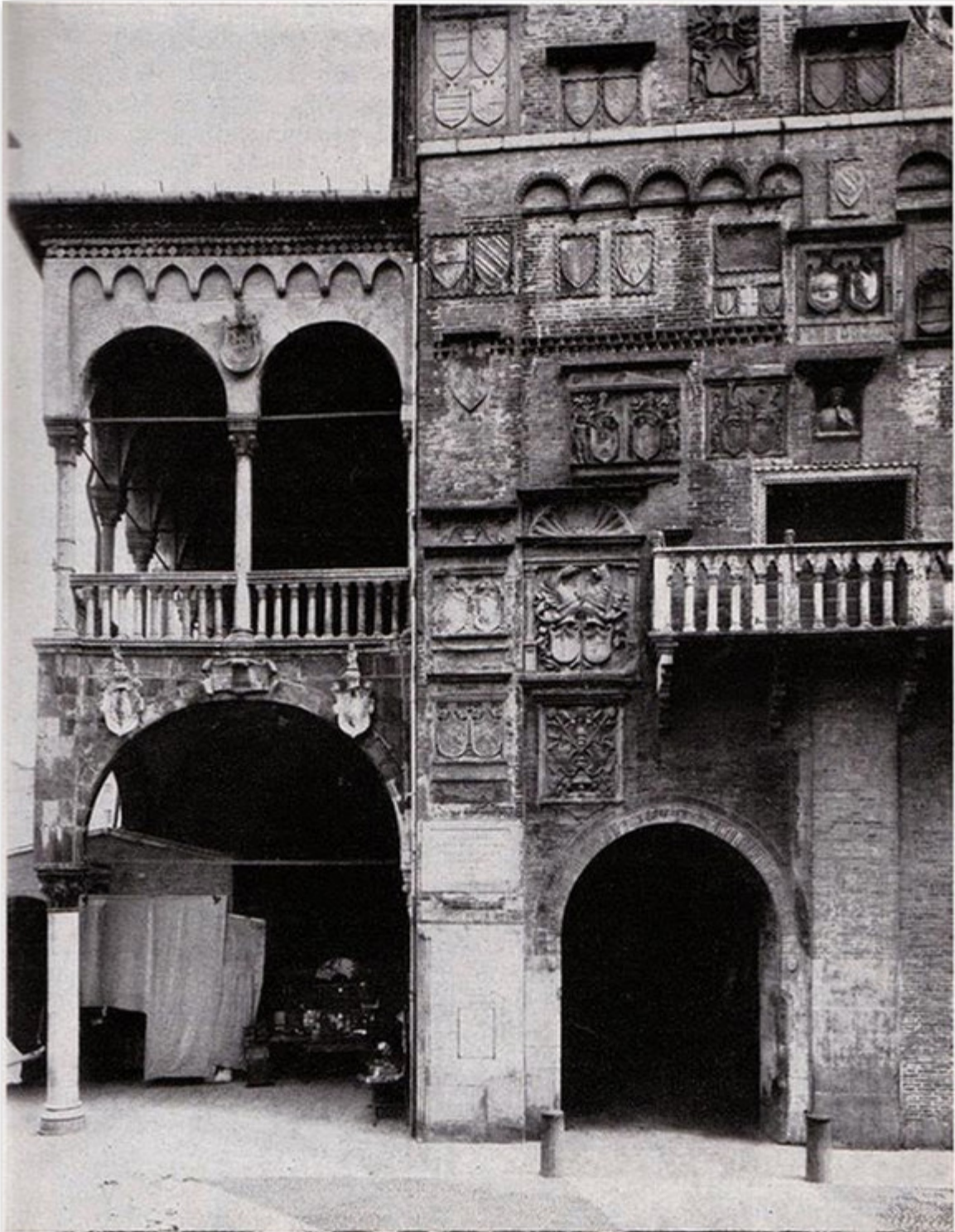
Fig. 55 - Sala della Ragione: facciata occidentale
